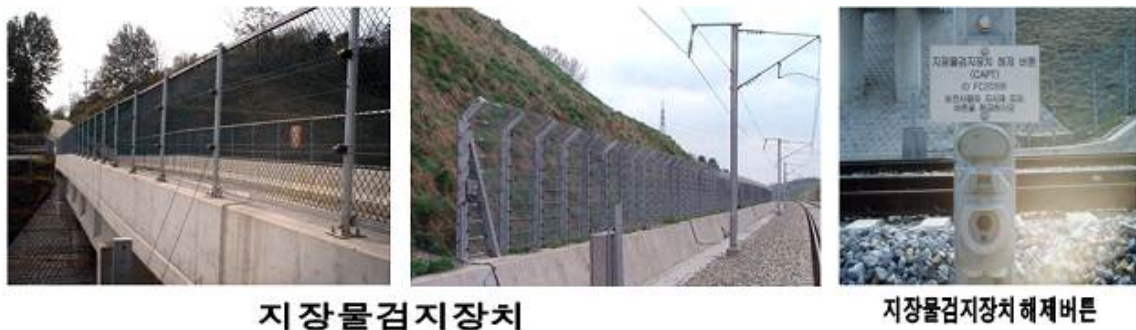
그림 2. 지장물 검지장치 설치
