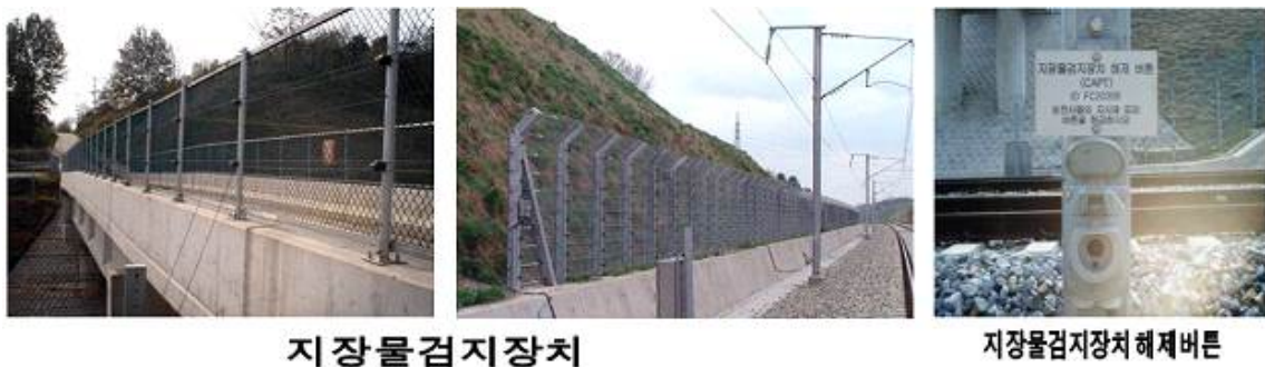
그림 2. 지장물 검지장치 설치
