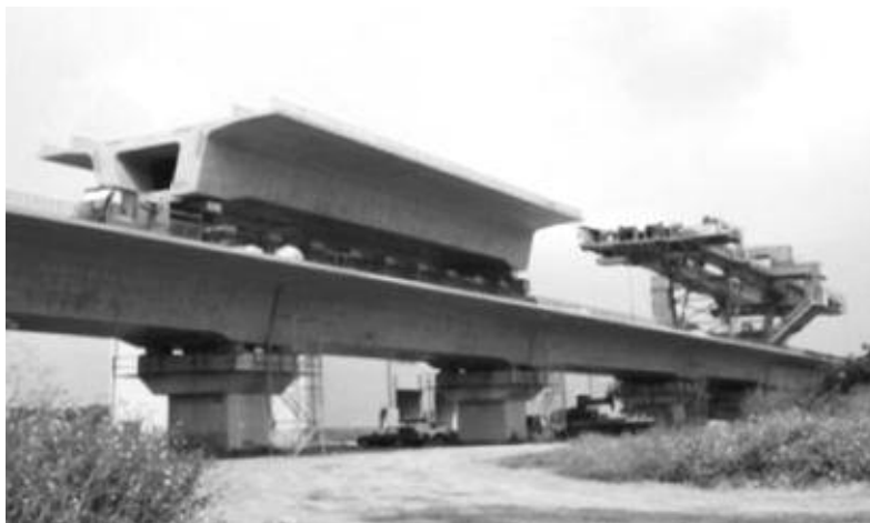
그림 12. Launching Girder+Tire Trolley+Lifting 시스템
