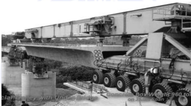
그림 13. Special Trolley+Under-Bridge 시스템
