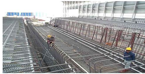
② 쉬스관(Post-Tension용 Sheath관) 설치
