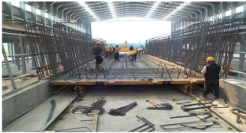
① 바닥 및 벽체(Bottom/Web) 철근 조립
