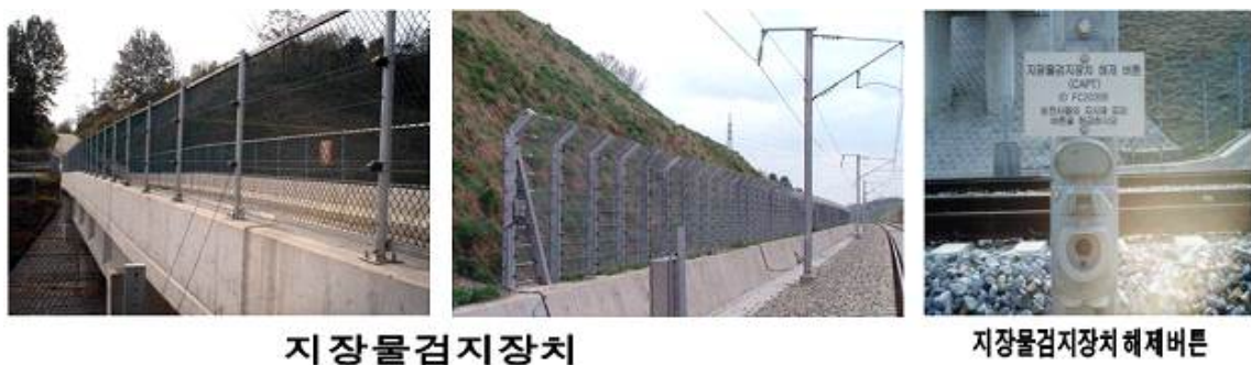
그림 2. 지장물 검지장치 설치
