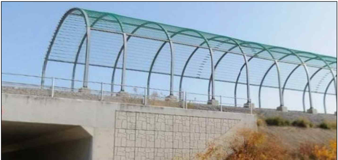
<터널형 안전울타리 기존 설치 현황>
