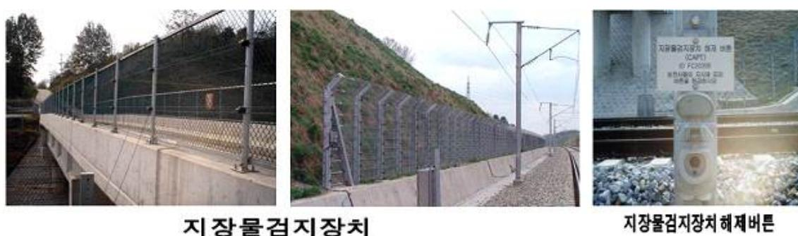
그림 2. 지장물 검지장치 설치
